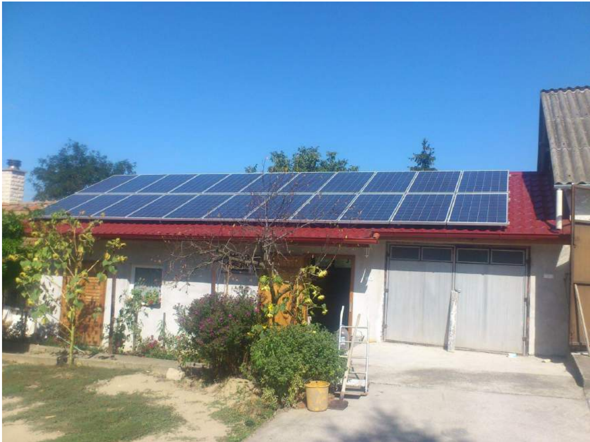
5,5 kW-os napelemes rendszer. Forrás: megujuloenergiak.eu
